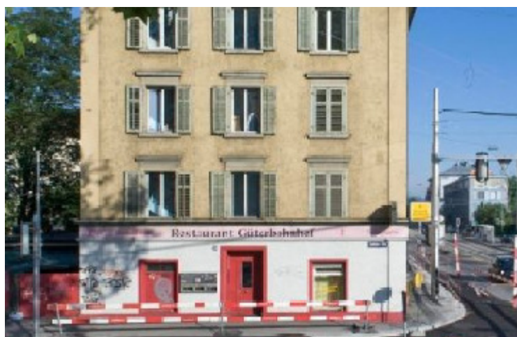
Rest. Güterbahnhof, Hohlstr. 147, 8004 Zürich
